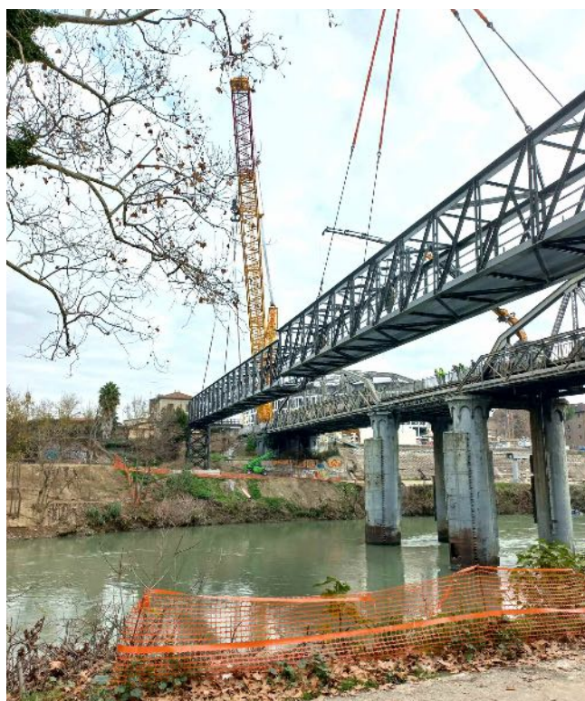
“Cantiere a Ponte dell'Industria”
