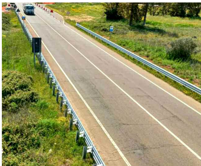
Barriere di sicurezza stradali in acciaio TSO
