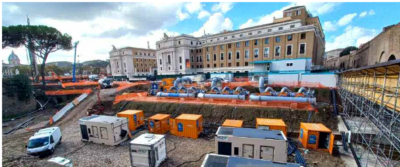
"Cantiere a Piazza Pia"
